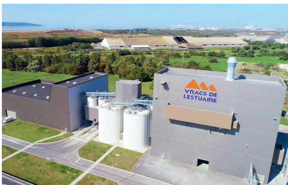
→ L'usine de broyage de clinker est implantée au sein de la zone industrialo-portuaire du Havre.
