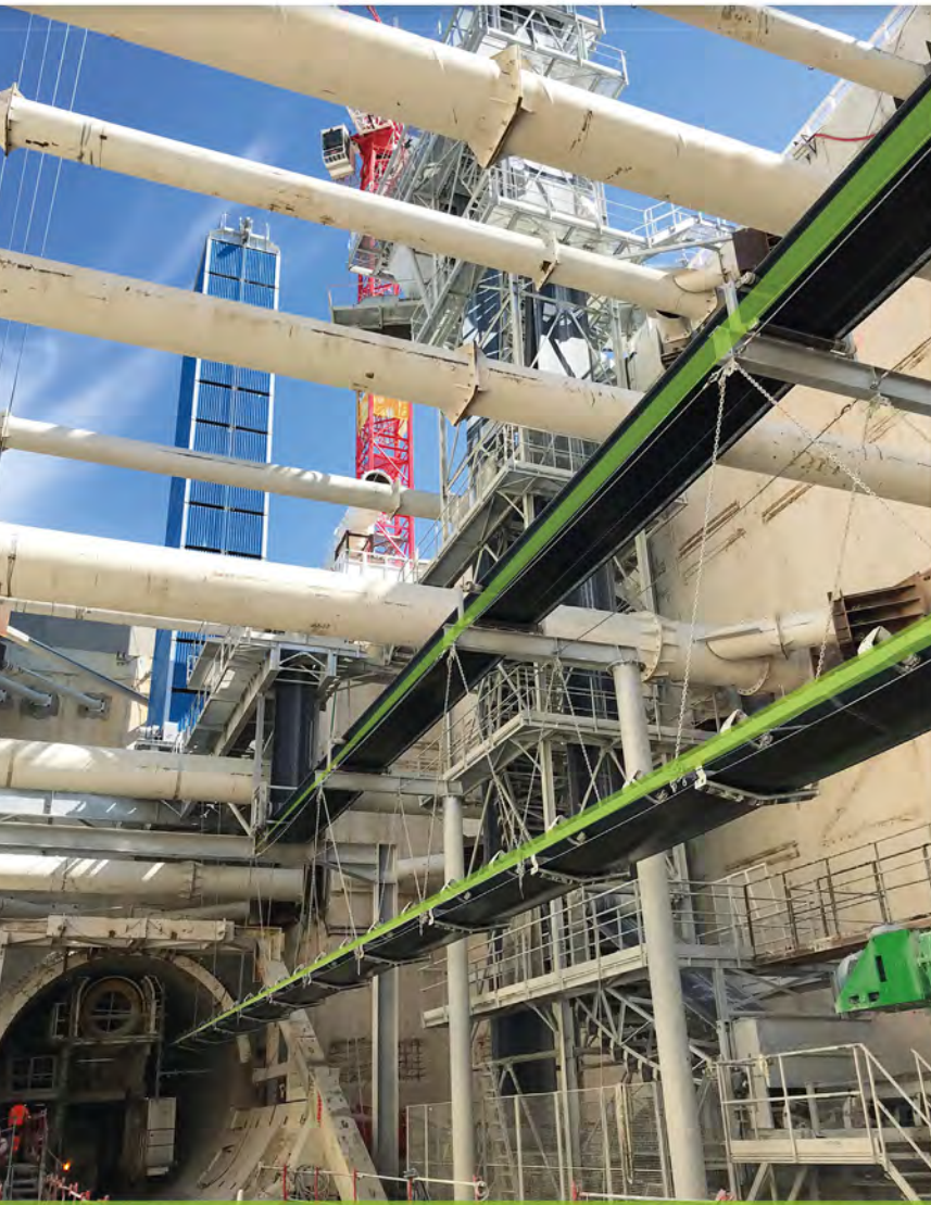
Projet L14 GC03 - Grand Paris Réserve de bande verticale, bande 1000mm // ZZBelt 32m
